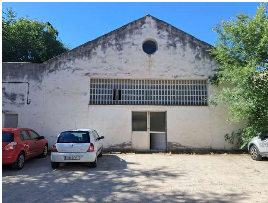
Acceso actual al edificio
