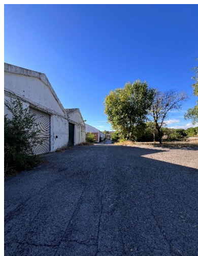
Naves industriales zona norte (cocheras)
