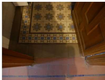
Detalle solado baño
