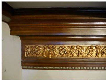
Detalle fajeado cornisa
