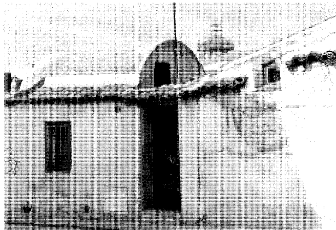
Solución singular con muros de tapial y cubierta abovedada en la calle del Lobo, 12. María Cristina García, 2000.
