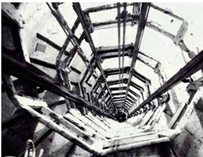
Montaje sobre suelo de la unión de los brazos de la cruz para comprobación técnica
