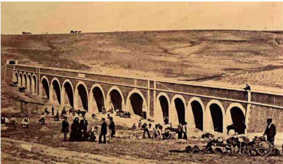
Acueducto del Amaniell en construcción en la segunda mitad del siglo XIX y forma parte de las obras del Canal de Isabel II.
