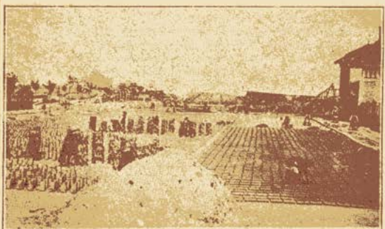
FABRICACIÓN DE LADRILLOS CON TIERRAS DE LA EXPLANACIÓN DE CALLES
