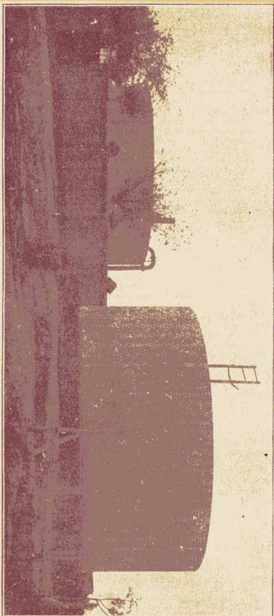
DEPÓSITOS DE AGUA DE 300 METROS CÚBICOS CADA UNO, EN LA MANZANA 79
