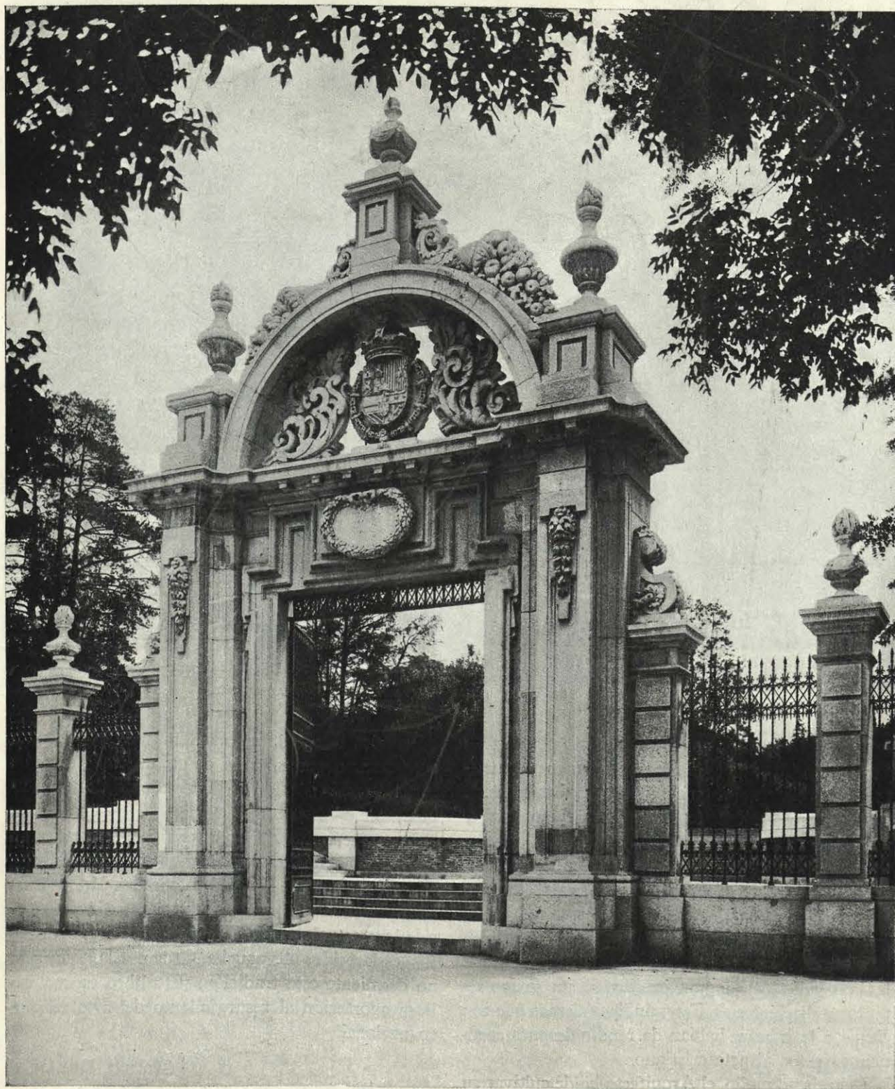
PUERTA DE ANA DE NEBOURG (ACTUALMENTE EN EL PARTERRE DEL RETIRO). Restauración del Arquitecto D. Luis Bellido . Fot. Lladó.
