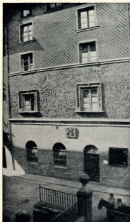
ESTADO ACTUAL DE LA CASA DE JÁUREGUI.
