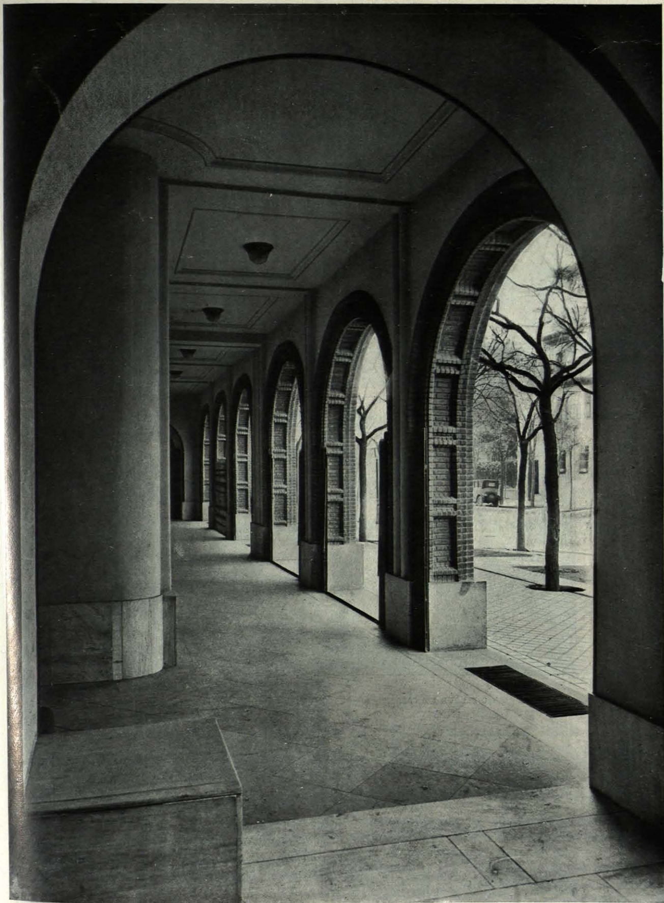
DETALLE DEL PÓRTICO.
