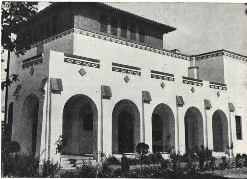
PABELLÓN DE ARAGÓN (SEVILLA).
