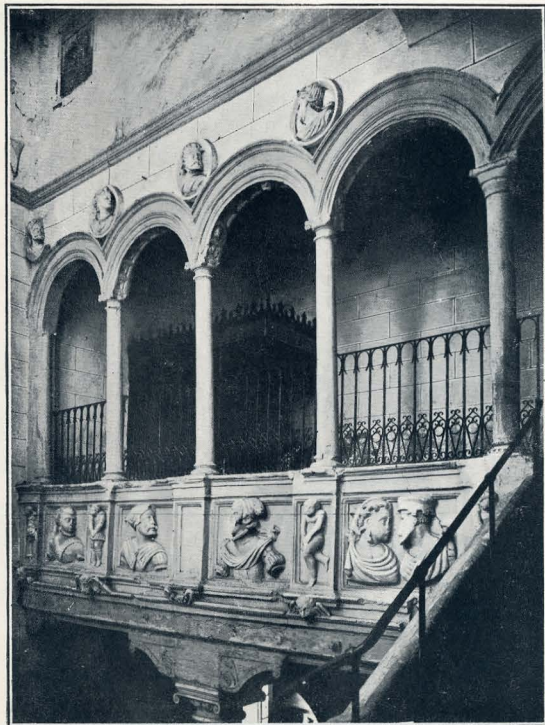
ANTEPECHO DE LA ESCALERA DE LA CASA CONSISTORIAL DE HUESCA. Fots. F. Oltra.
