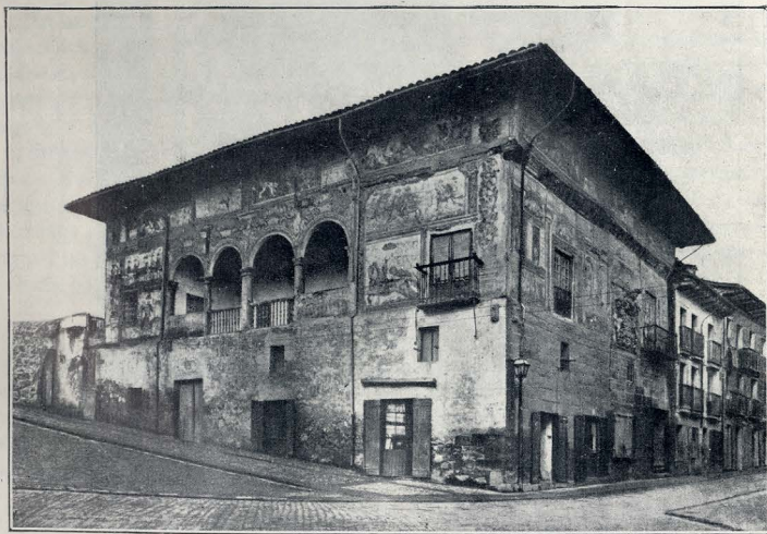
GUERNICA. — CASA DE LOS CONDES DE MONTEFUERTE.
