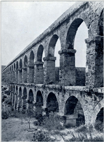
EL ACUEDUCTO DE TARRAGONA.
