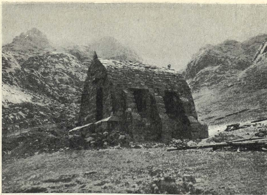
MACIZO DE PEÑA SANTA DE LOS PICOS DE EUROPA. REFUGIO DE VEGA-REDONDA. Arquitecto: Julián Delgado.
