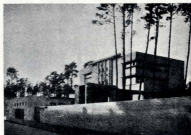
UNA CASA ORGÁNICA. FÁCILMENTE APRECIABLES LAS DIVISIONES HORIZONTALES Y LA COMUNICACIÓN VERTICAL DE LA ESCALERA. CONSTRUÍDA DE DENTRO AFUERA Y CON SENTIDO SEGURO DE LA ESTABILIDAD EN EL INTERIOR, Y UNIDA AL PAISAJE EXTERIOR.
