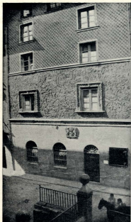
ESTADO ACTUAL DE LA CASA DE JÁUREGUI.
