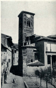
DAROCA.—IGLESIA, DESTRUIDA, DE SANTIAGO.
