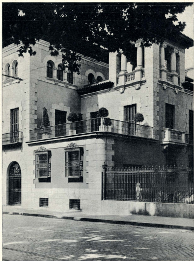
PALACIO EN EL PASEO DEL PRADO.
