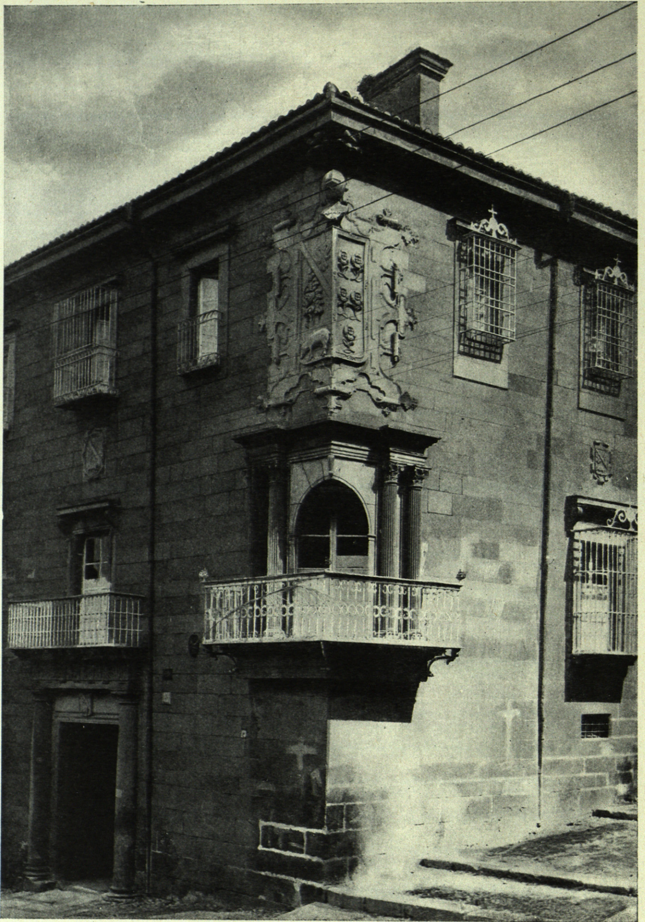
PLASENCIA.—CASA DEL DEAN.
