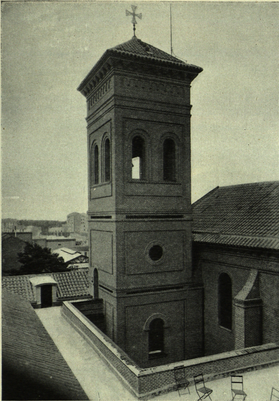
MADRID.—IGLESIA NUEVA DE S. ANTONIO. VISTA DE LA TORRE.
