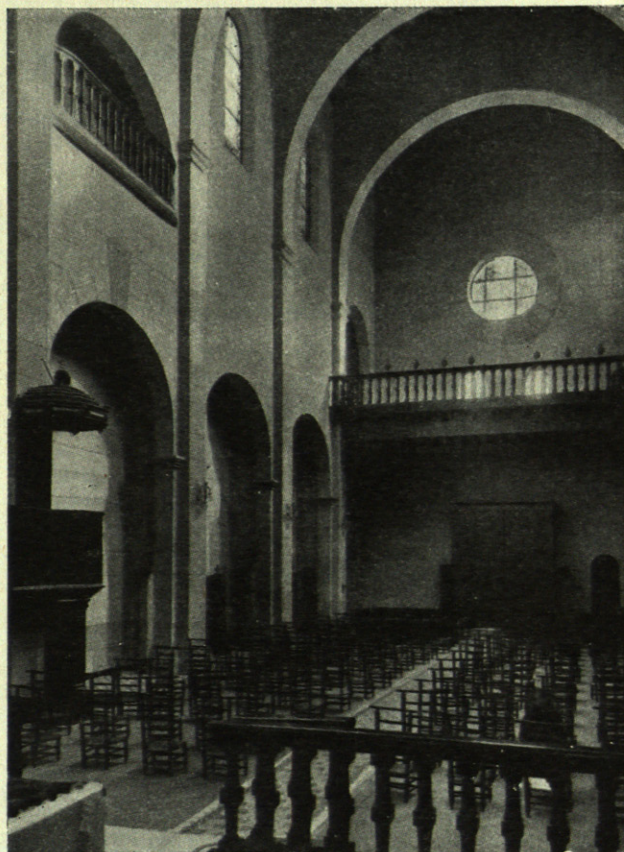
INTERIOR DESDE EL ÁBSIDE.
