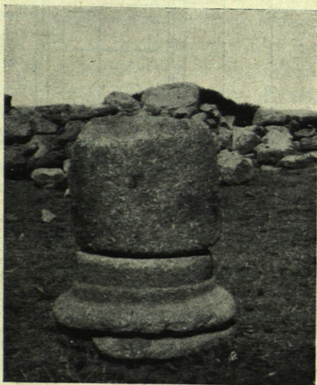
PIEDRAHITA.—BASA Y TROZO DE FUSTE HALLADOS EN LAS EXCAVACIONES.
