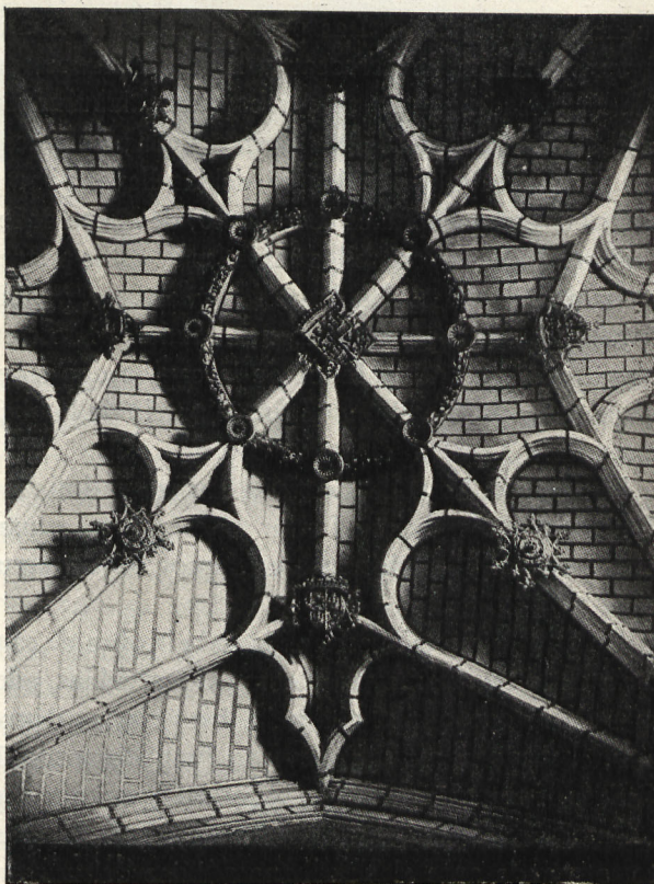
BÓVEDA EN LA CAPILLA DE LOS REYES NUEVOS.
