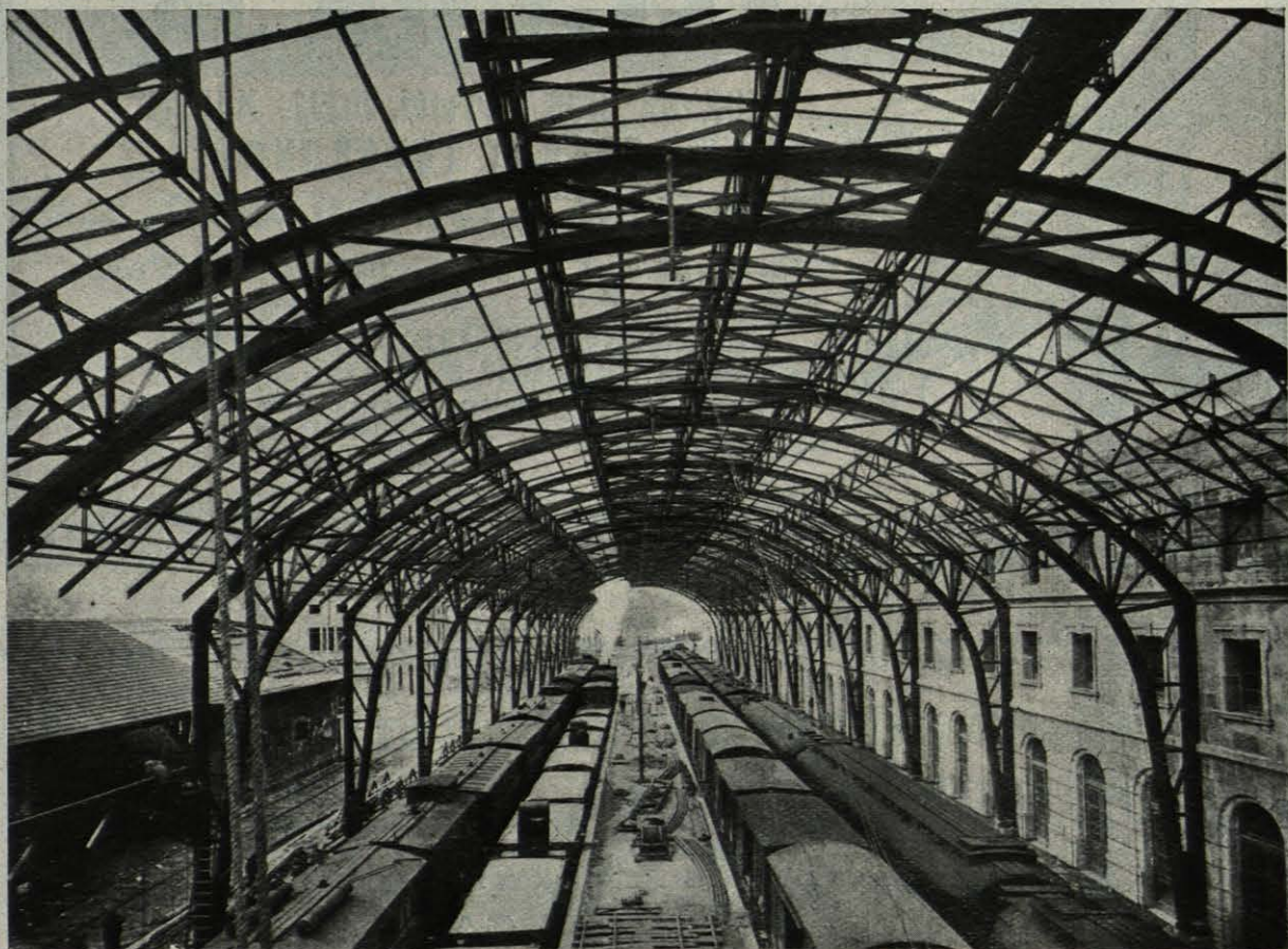
Estación internacional de Port-Bou.—Cubierta de andenes.—Agosto-Diciembre 1928.
