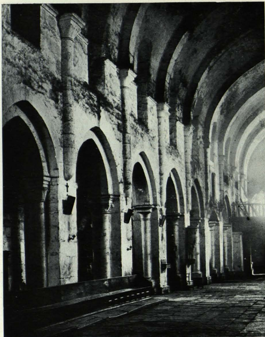
MEIRA. INTERIOR DE LA IGLESIA.
