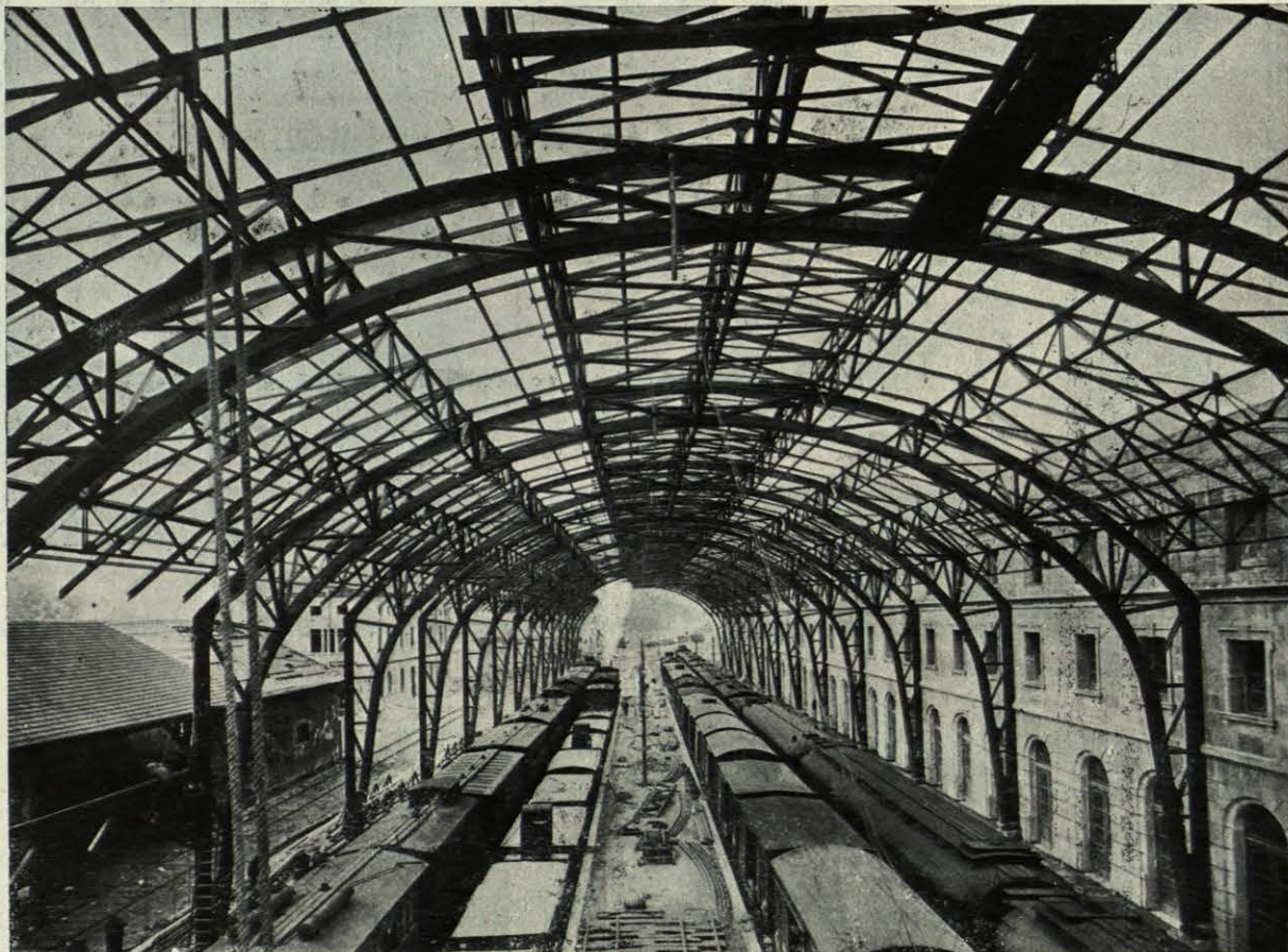
Estación internacional de Port-Bou. —Cubierta de andenes.— Agosto-Diciembre 1928.
