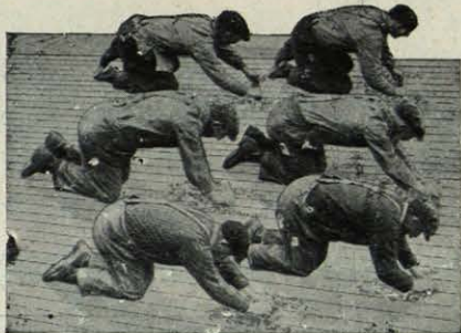
Sistema anticuado de acuchillar pisos.
