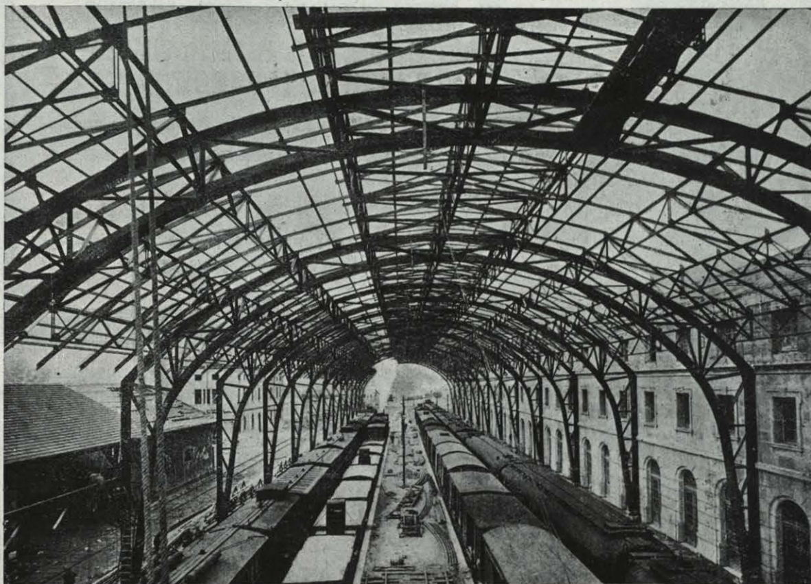
Estación internacional de Port-Bou.—Cubierta de andenes.—Agosto-Diciembre 1928.
