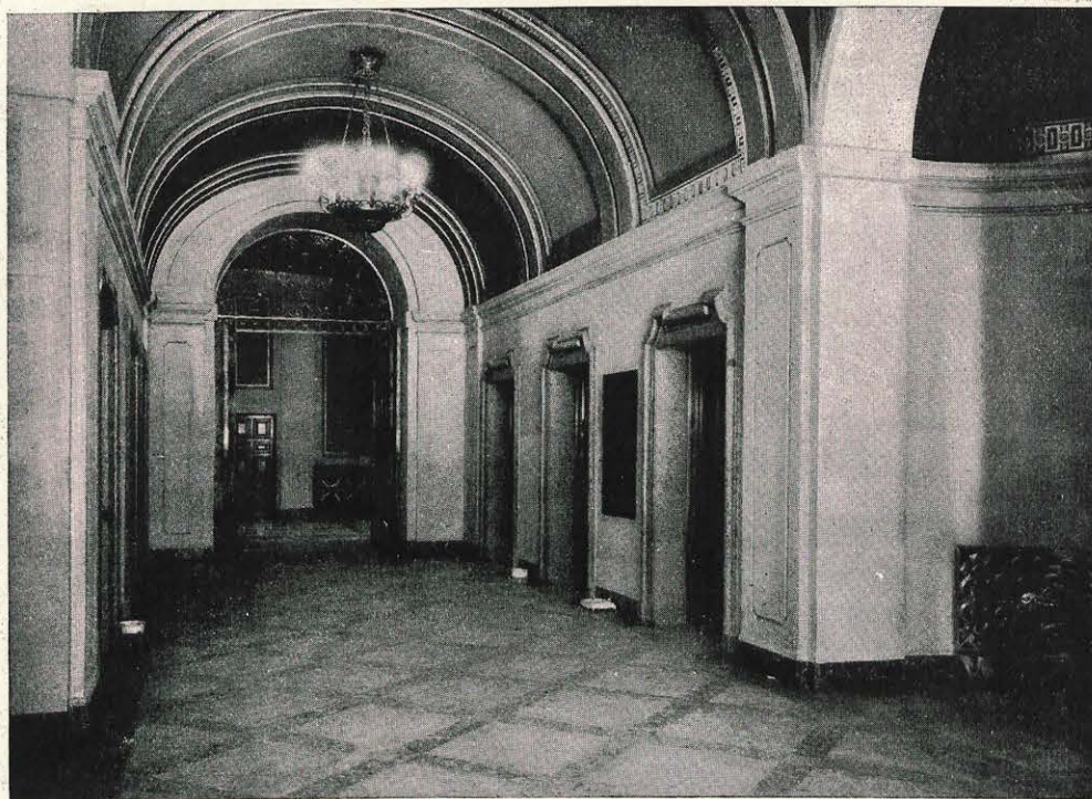
VESTIBULO DE ASCENSORES. (TELEFONICA.)
