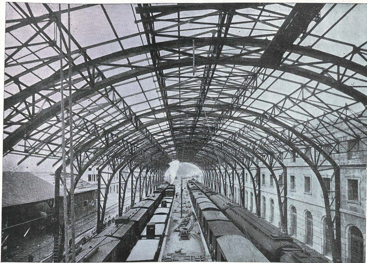
Estación internacional de Port-Bou. —Cubierta de andenes.—Agosto-Diciembre 1928.
