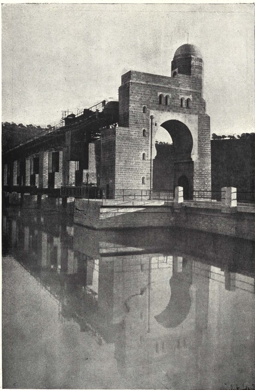
PRESA DE CARPIO.
