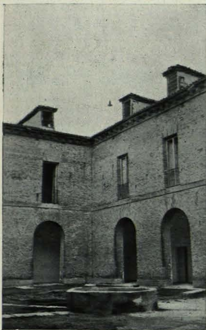
PATIO DE LA CASA-PALACIO DE "LA ISABELA"
