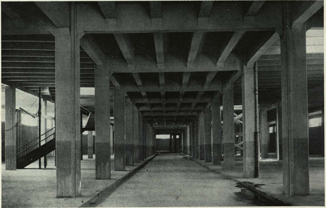
Mercado Central de Frutas y Verduras. Interior de la planta baja.
