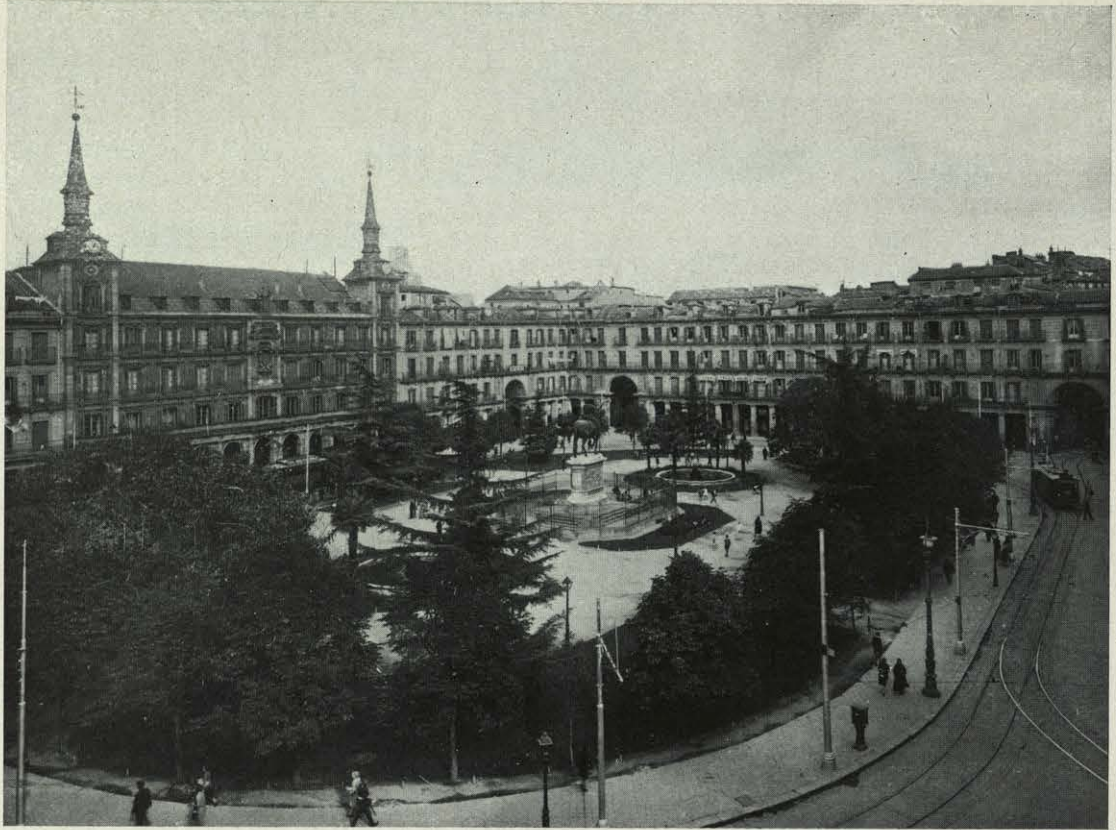
Estado actual de la Plaza Mayor.
