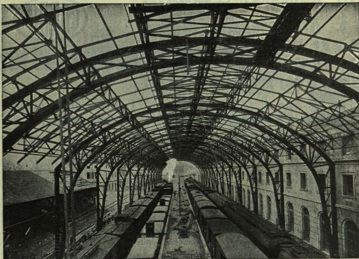
Estación internacional de Port-Bou.—Cubierta de andenes.—Agosto-Diciembre 1928.
