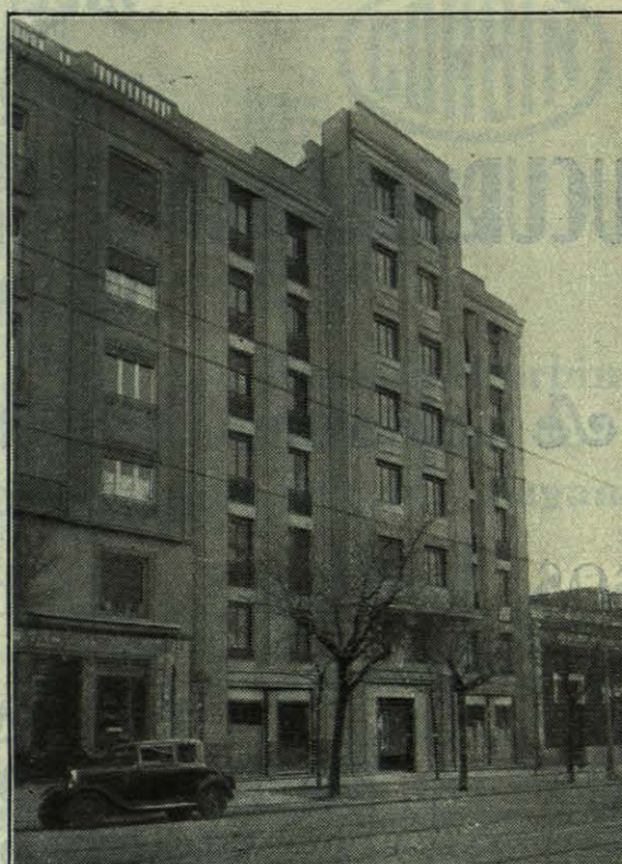
Magnífica casa moderna en Goya 40, en Madrid, construída por el arquitecto D. Plácido Francés, en la que se ha instalado Frigidaire en cada uno de los pisos
