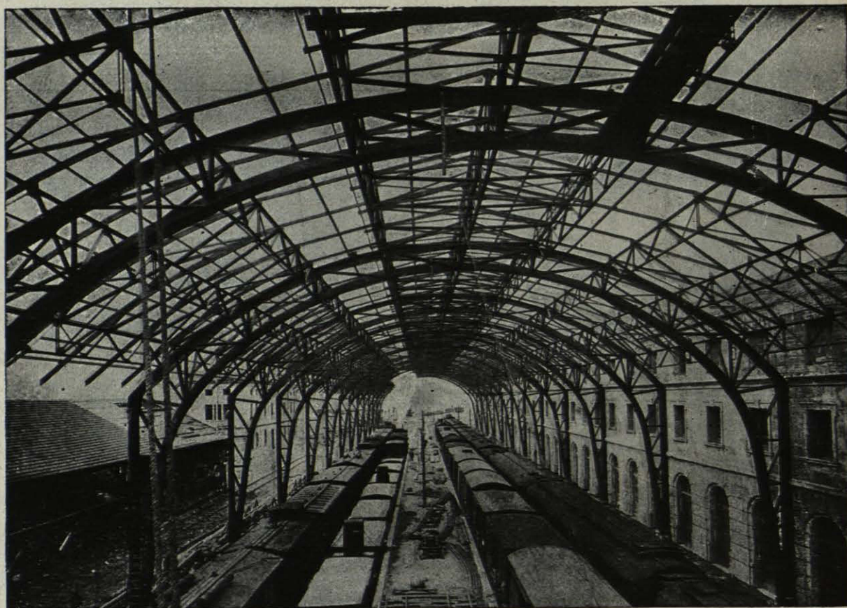
Estación internacional de Port-Bou.—Cubierta de andenes.—Agosto-Diciembre 1928.
