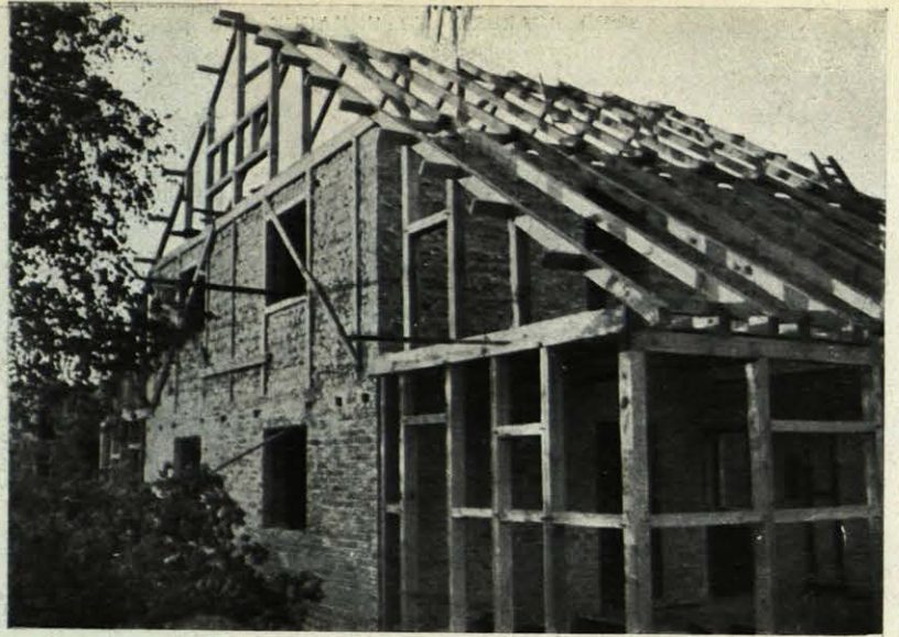
STADTRANSIEDLUNG (POTSDAM, 1933). LA PARTE DE VIVIENDA ES DE FABRICA DE LADRILLO; EL ESTABLO Y VESTIBULO SON DE ENTRAMADO DE MADERA
