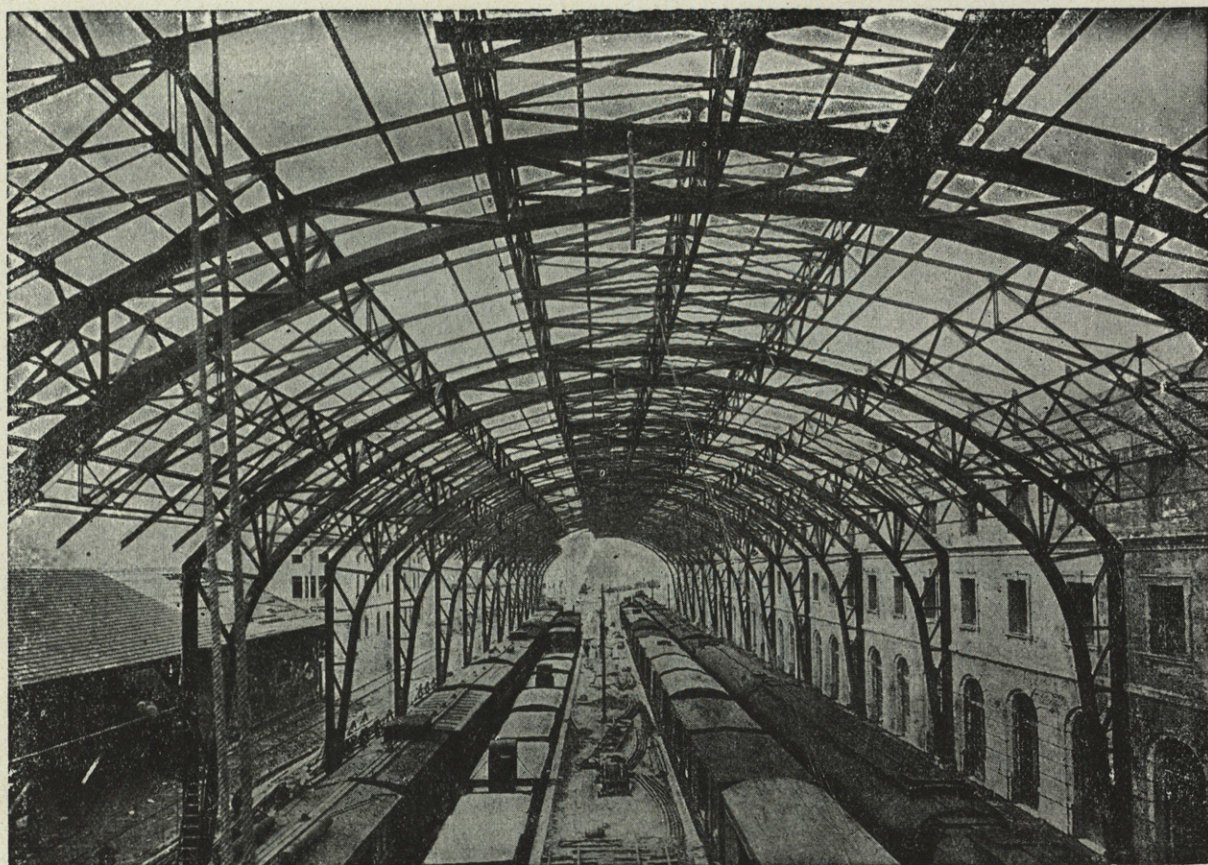
Estación internacional de Port-Bou.—Cubierta de andenes.—Agosto-Diciembre 1928.
