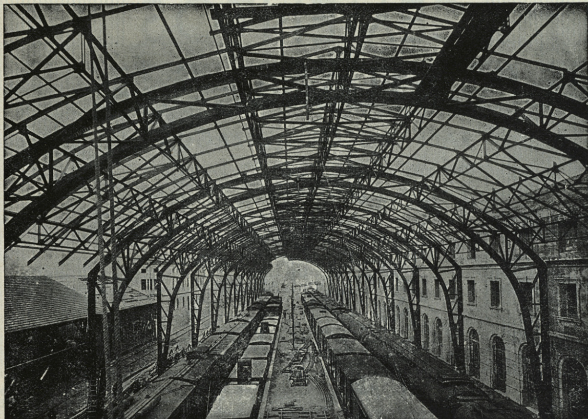
ESTACION INTERNACIONAL DE PORT-BOU -- CUBIERTA DE ANDENES -- AGOSTO-DICIEMBRE 1928
