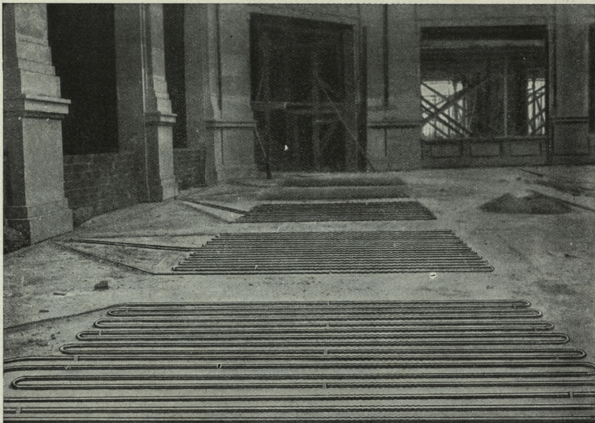
Instalación de calefacción por paneles en el Hall central de público del nuevo edificio del Banco de España en Madrid.
