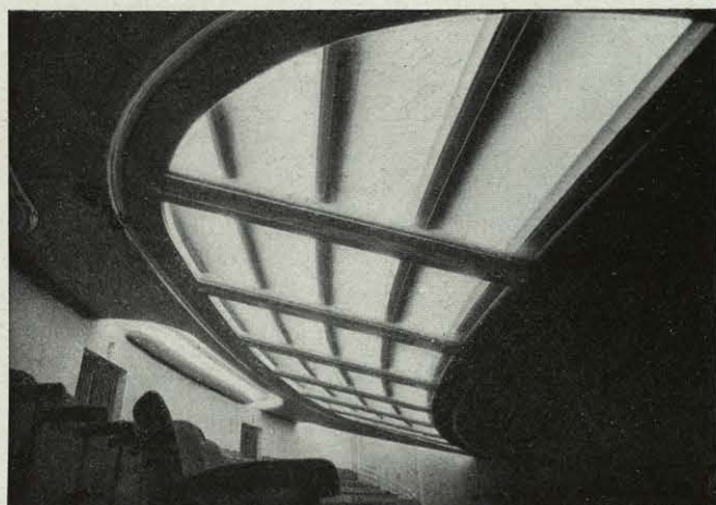
Techo del entresuelo.
