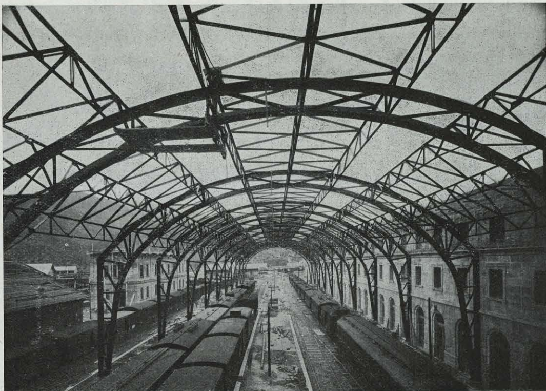
ESTACIÓN INTERNACIONAL DE PORT-BOU - CUBIERTA DE ANDENES - AGOSTO-DICIEMBRE 1928
