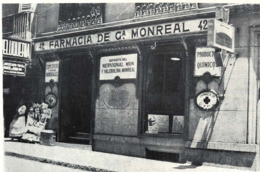
Fachada antes de la reforma.
