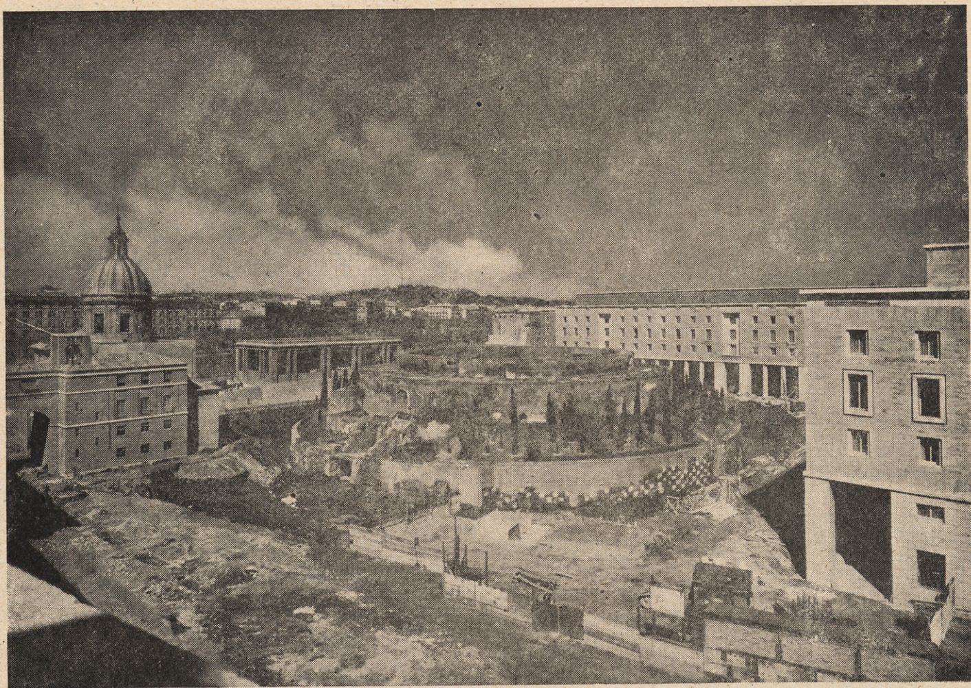
Estado actual de las obras.—Arquitecto, V. Ballio
