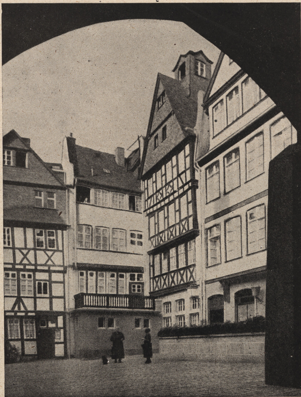
El ángulo Noroeste después de la restauración
