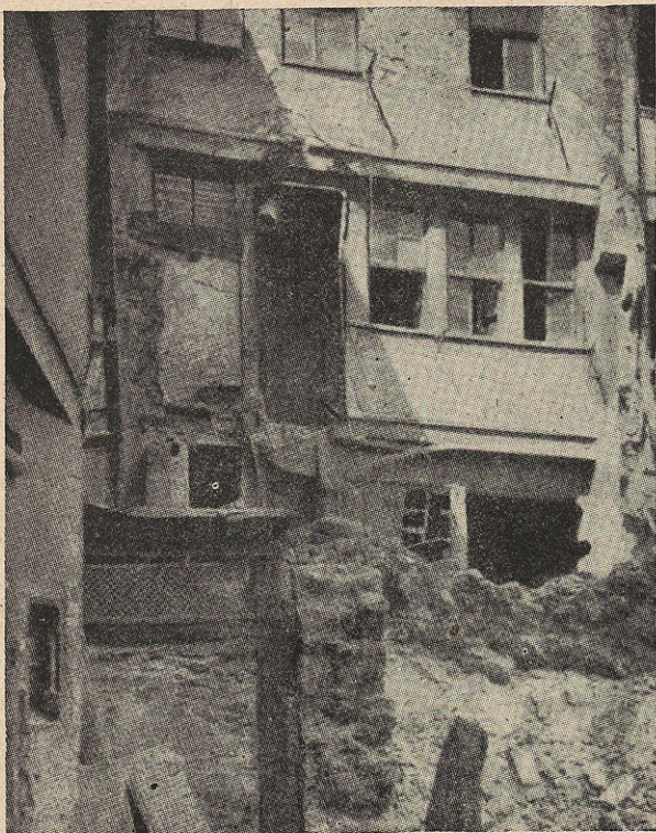
Obras de demolición en el saneamiento del án- gulo Noroeste de la nueva plaza
