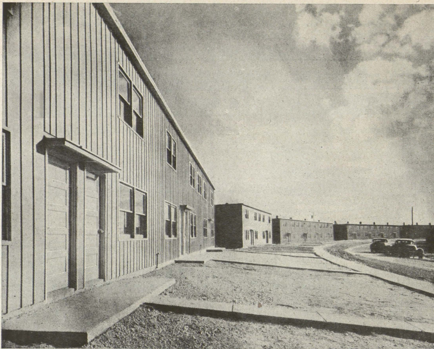
Un grupo de las viviendas de Center Line ya terminadas.
