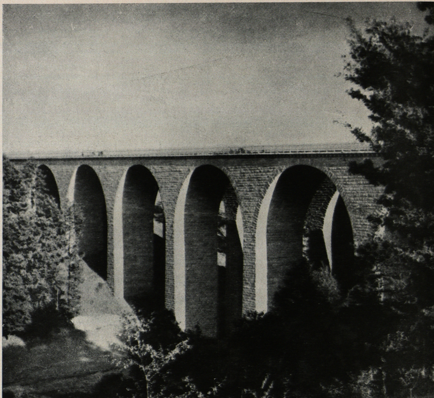
Pablo Bonatz. Puente sobre el valle Waschmühlle.
