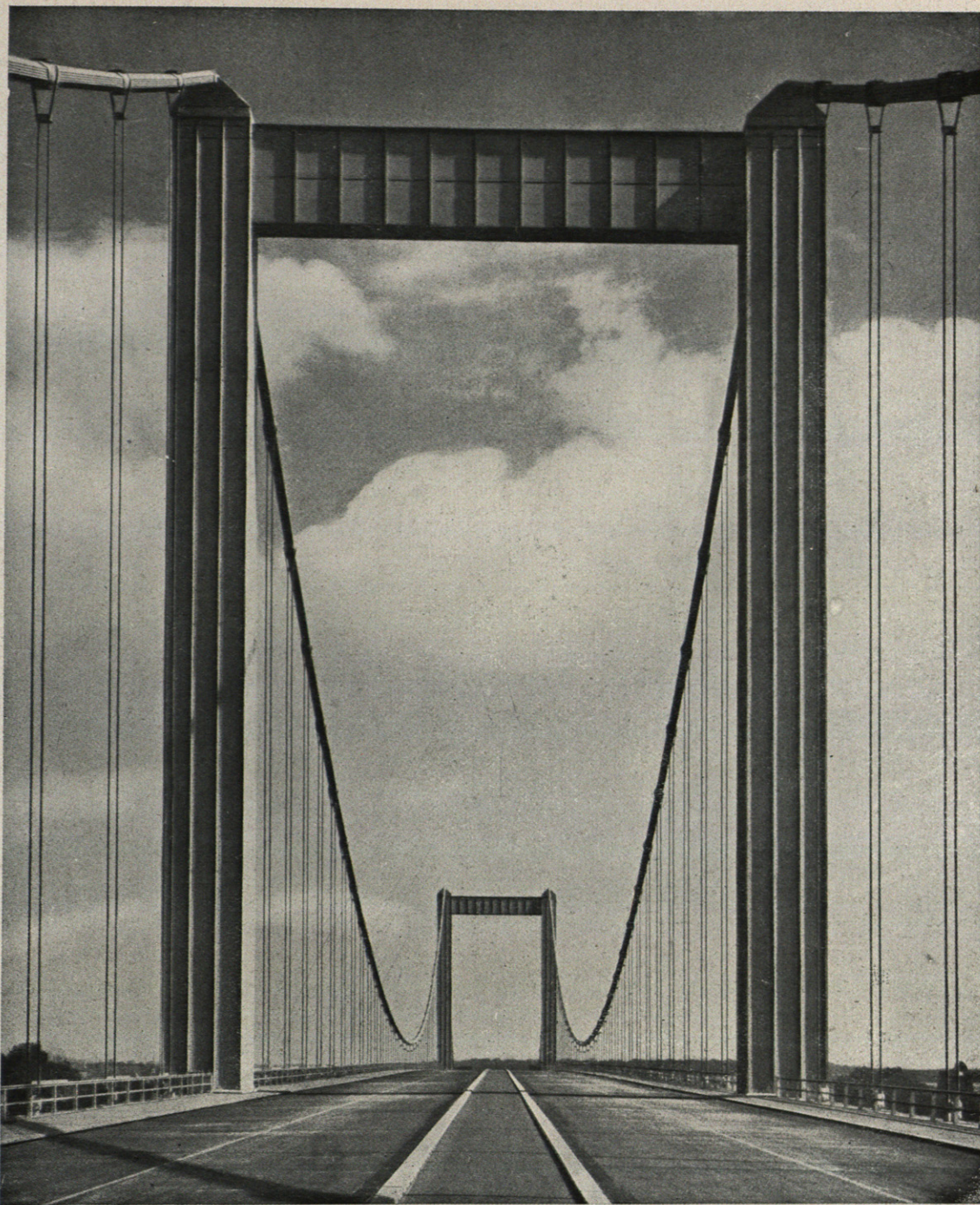
Puente colgante sobre la autopista, 1938 a 1941. Ingeniero: K. Schaechterle, F. Leonhardt; arquitecto: Pablo Bonatz. Vista desde el centro de la autopista.
