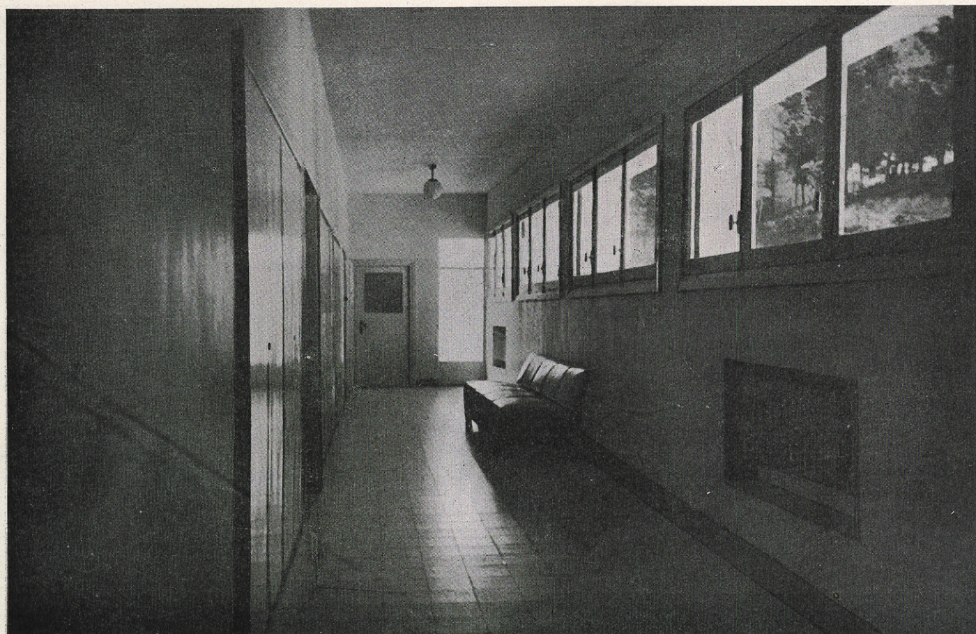
Pasillo de dormitorios.
