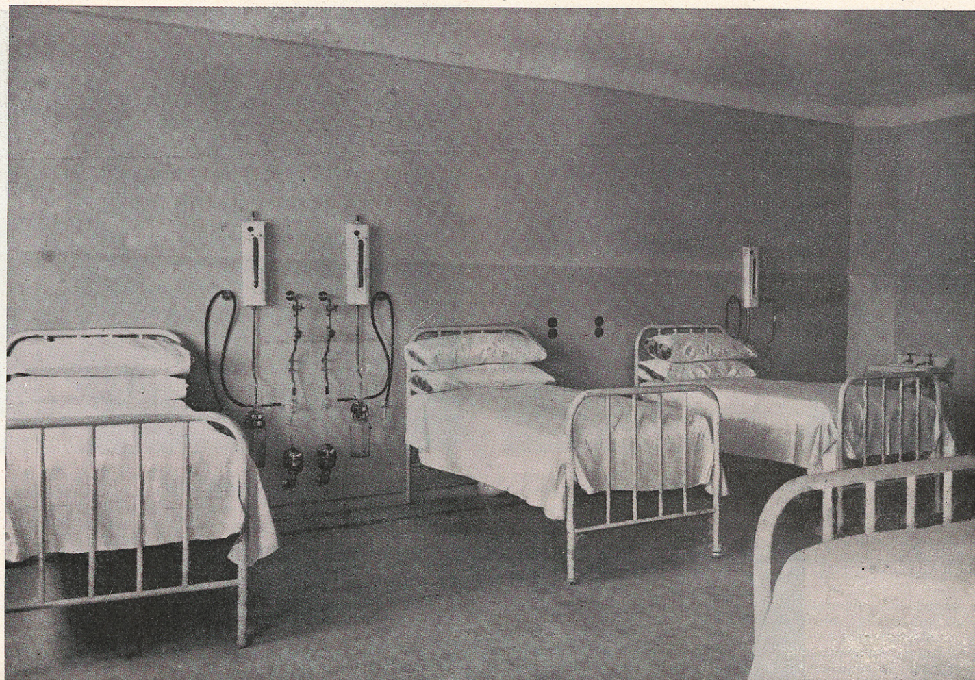
Habitación de cinco camas, con instalación de trompas de Bonaldi para aspiración.
