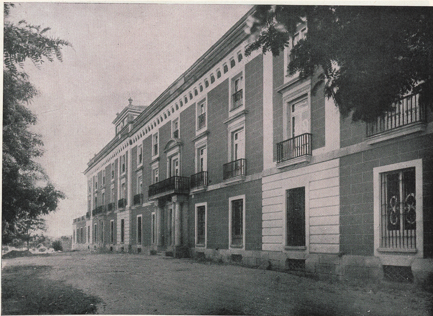
Fachada NO., reconstruida.
