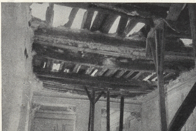
Un aspecto del interior al empezar las obras de reconstrucción.
