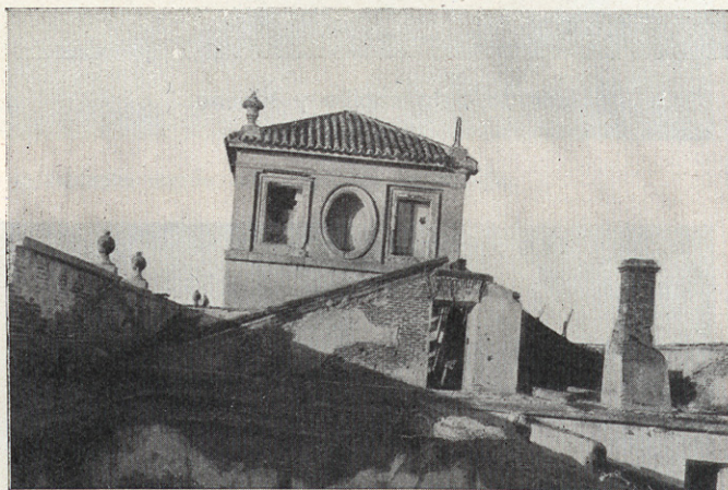
Estado en que se encontraba la cubierta.
