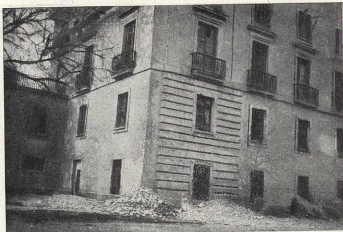
Vista parcial del edificio al empezar las obras.
