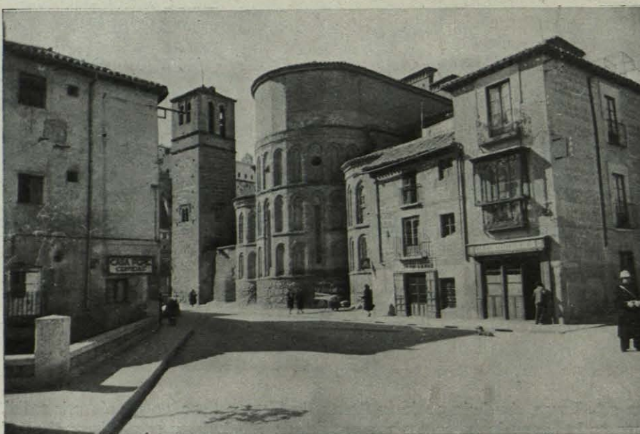
Las casas adosadas a Santiago del Arrabal.
