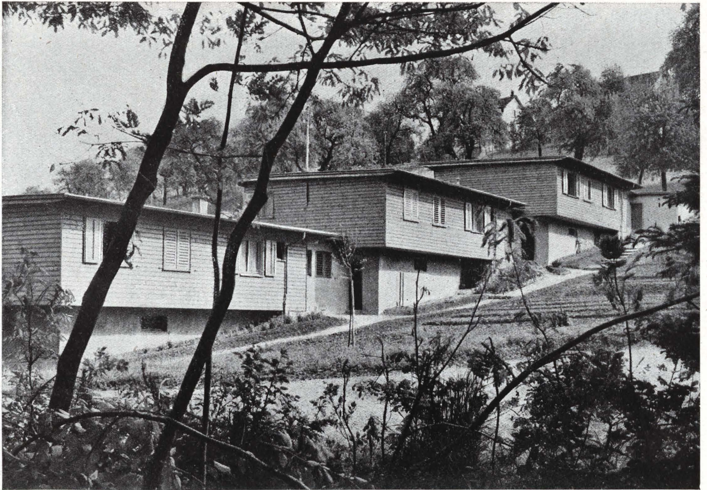
Parte posterior de las casas con las entradas
