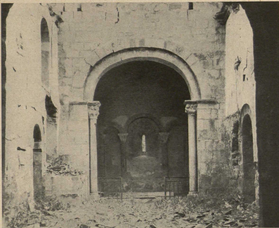
Fuentes: Iglesia de San Salvador. Interior de la nave, después del incendio y antes de ser restaurada.
