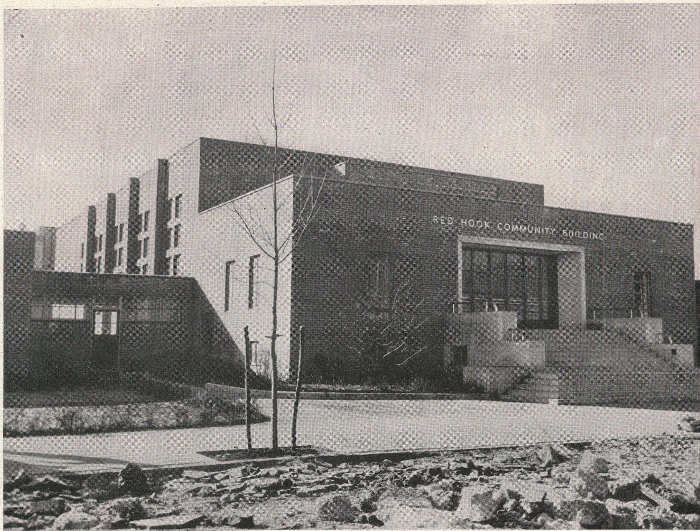
La Casa comunal de la barriada, donde están instalados casino y escuelas.
