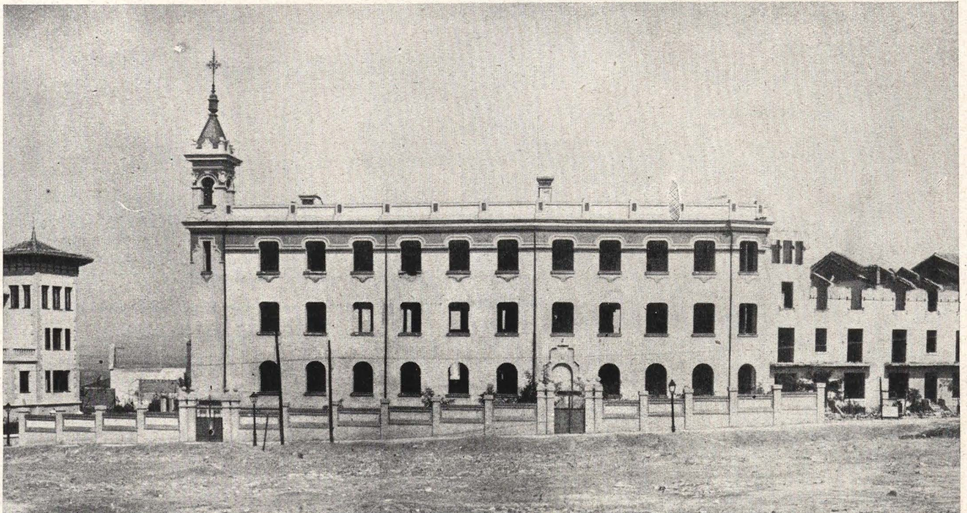
Hogar cuna. Estado primitivo del edificio.
