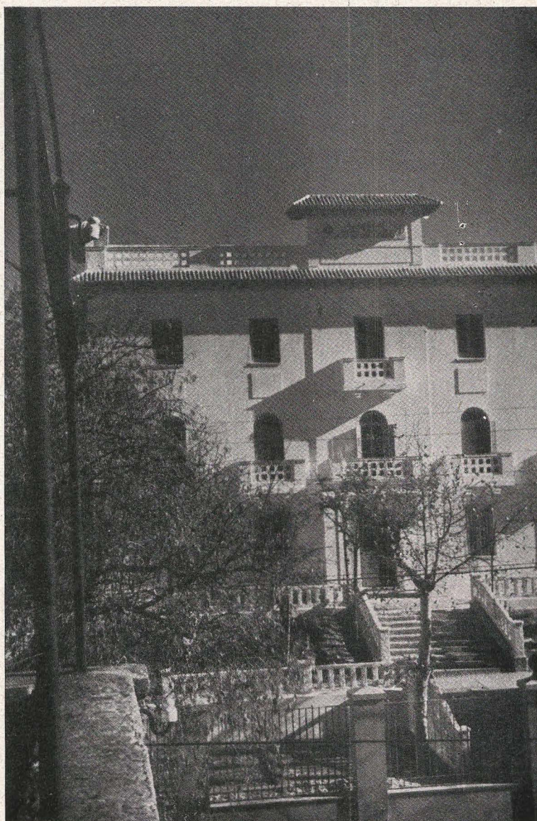
Fachada principal, transformada.
