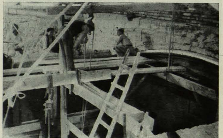
Preparación de las cimbras y reconstrucción de una bóveda del crucero.
