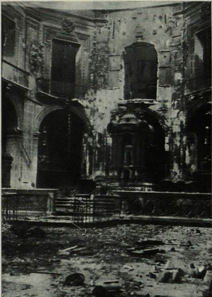
Estado en que quedó el Presbiterio y retablo mayor después del incendio de 1936.
