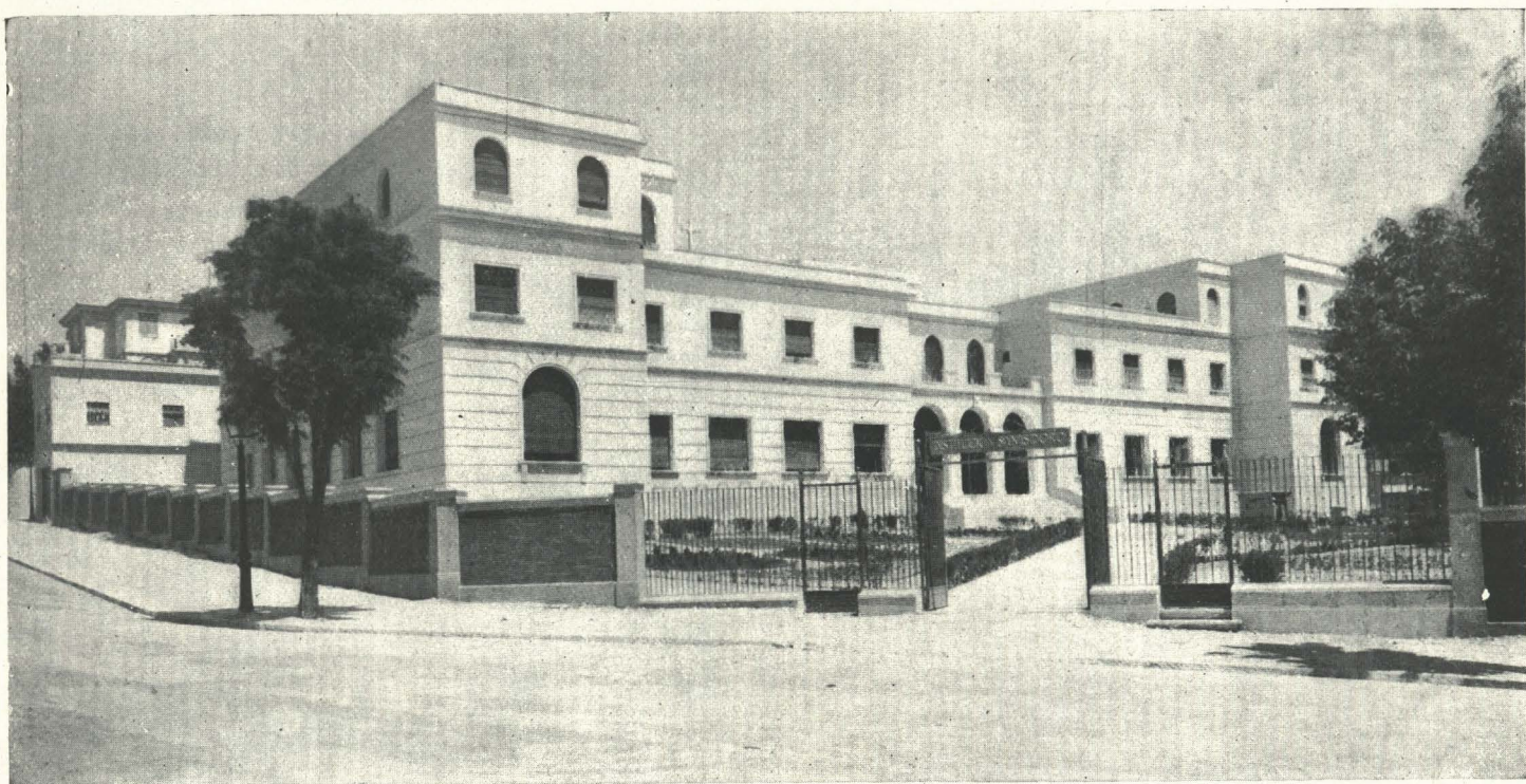
Vista general del edificio
