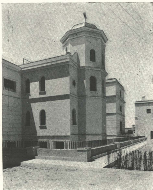
Detalle de la fachada posterior
