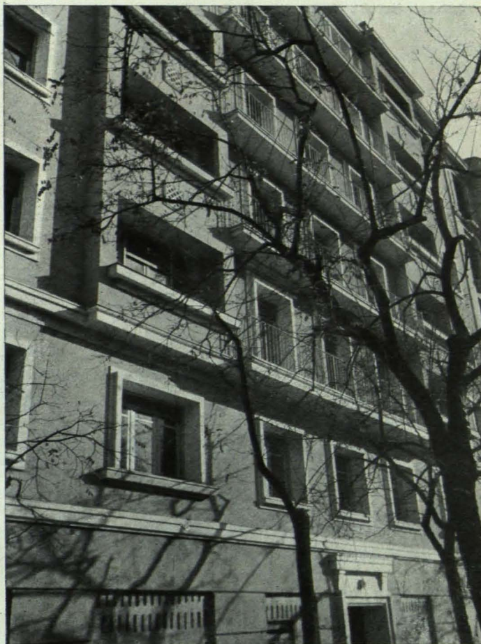
Detalle de fachada
