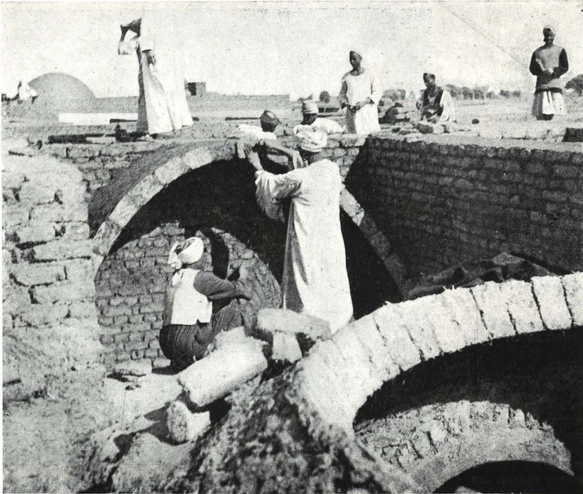
*Bóveda por anillos inclinados, construída sin cimbra de madera.*
