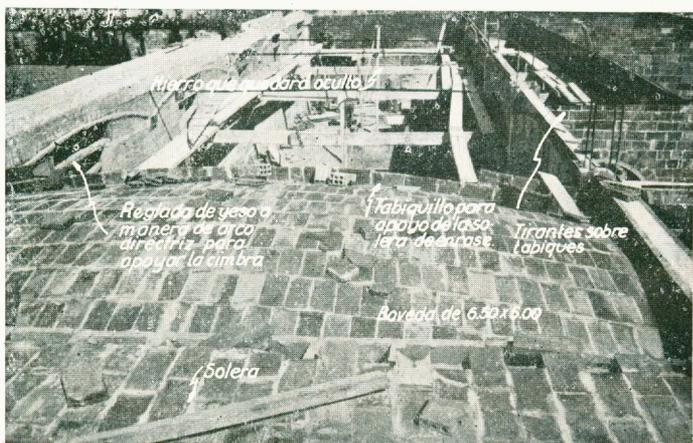
Al construir bóvedas independientes por las distintas dependencias, suprimimos totalmente los cielo-rasos, y podemos colocar por encima, fácilmente, las instalaciones eléctricas y desagües de sanitarios, aprovechando la pendiente existente en las mismas y por debajo del tablero de enrase.
