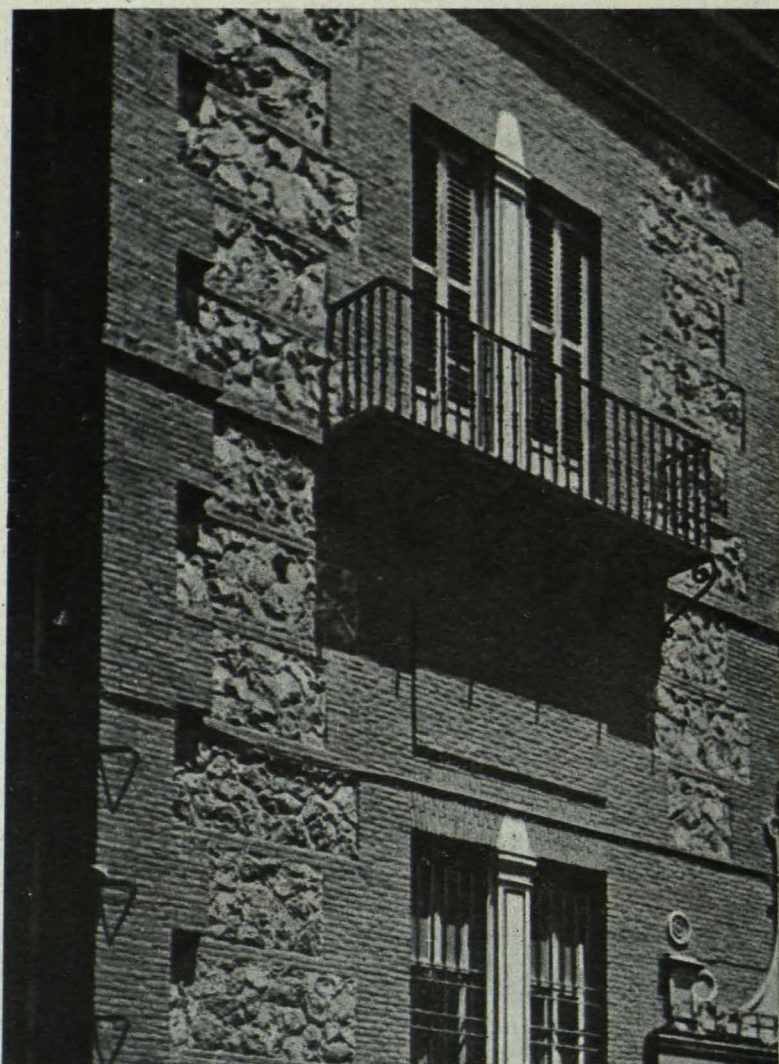
La combinación de la mampostería y el ladrillo, muy típica de las construcciones de Madrid anteriores al siglo XVI, se conserva aún en obras de época posterior, como vemos en la antigua casa llamada «de las Siete Chimeneas».
